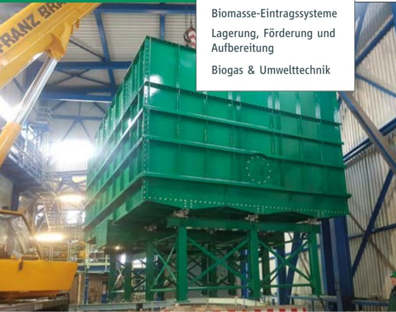
Einbringung der vormontierten Annahmestation in die Baugrube.
